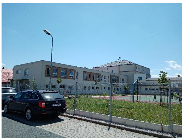
Obr. 32 Základní škola a tělocvična
