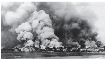
Zničené objekty v areálu Škodových závodů po americkém náletu
