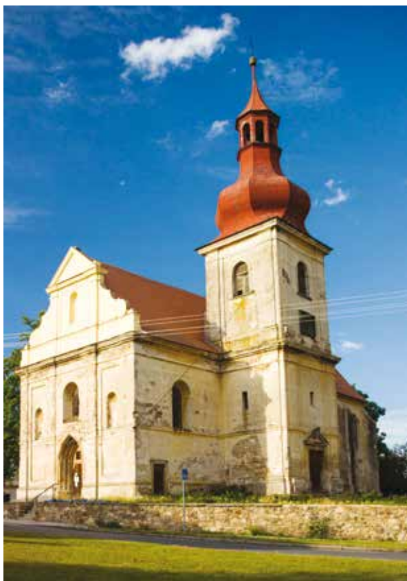
Současný stav kostela s nově opravenou opěrnou kamennou zdí a chodníkem (oprava financována obcí částkou 1 418 902 Kč)
