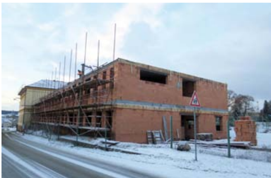
Budovy II. stupně ZŠ v době rekonstrukce
